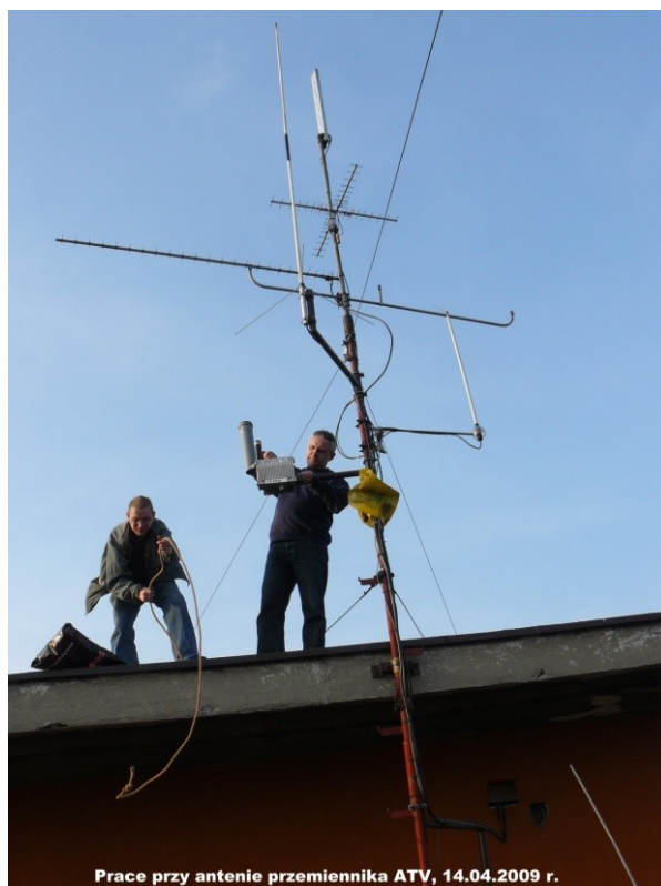
Andrzej SQ9IWG i Bogdan DL7AKQ/SP9RVF przy pracy montażowej anteny przebiegu ATV
