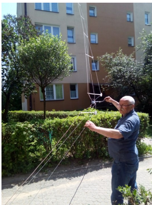
Marek SP2NNO kontrolujący wciąganie anteny KF na dach budynku
