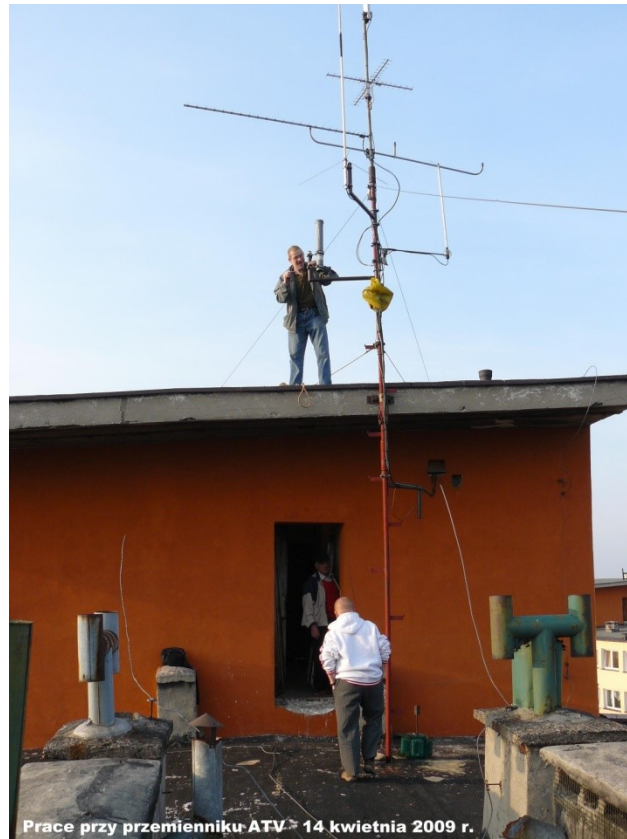
Andrzej SQ9IWG przy montażu anteny przemiennika ATV
