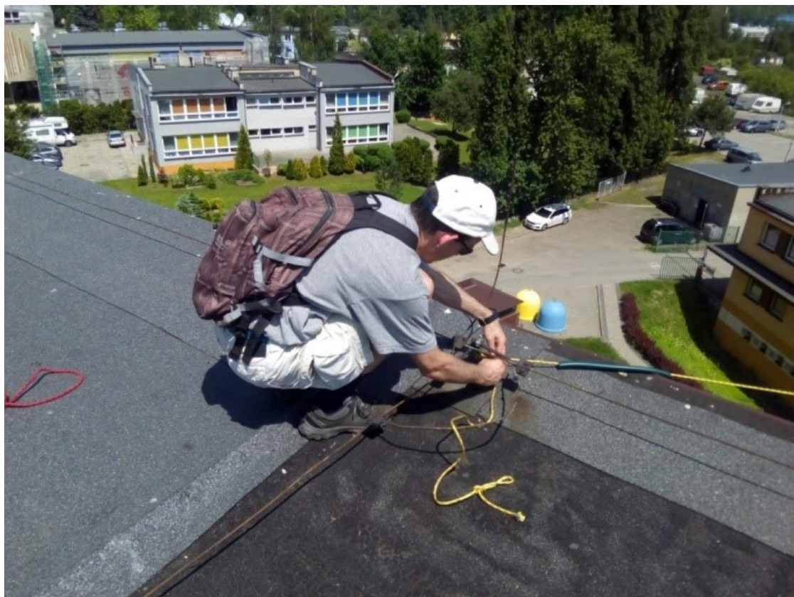
Wojtek SP9PWN nie boi się wysokości i dzielnie przytwierdza drugi odciąg od anteny KF na dachu sąsiedniego budynku.
